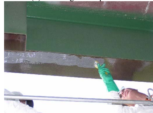
(d) Epoxy application on beam
