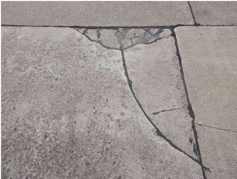
A01WA-05. Corner Break (Sample Unit No. 02).
