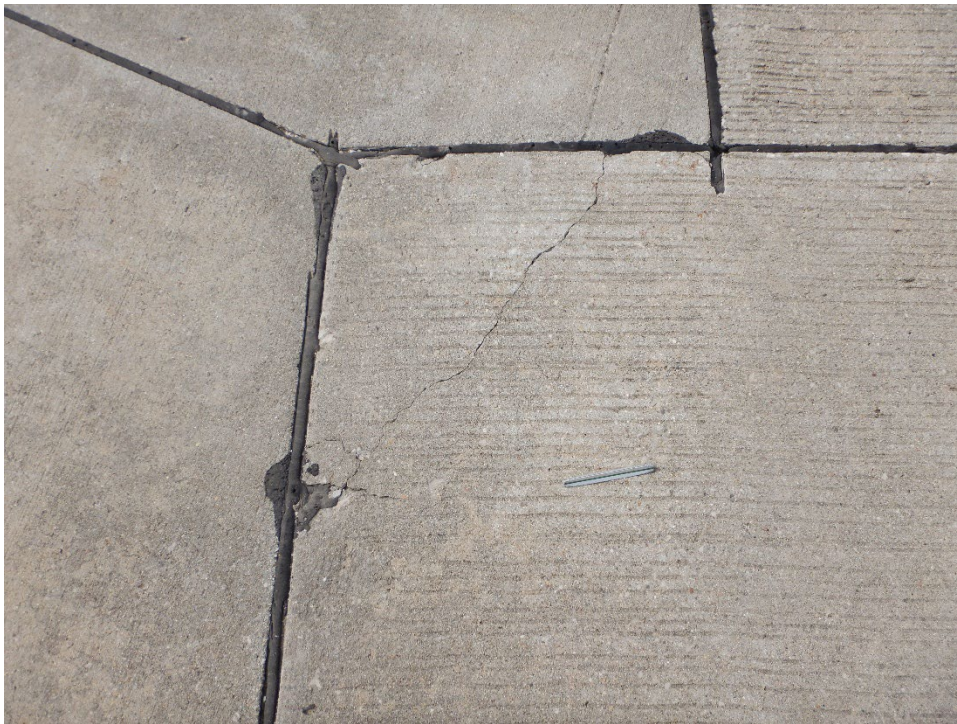
TA1WA-01. Corner Break (Sample Unit No. 02).
