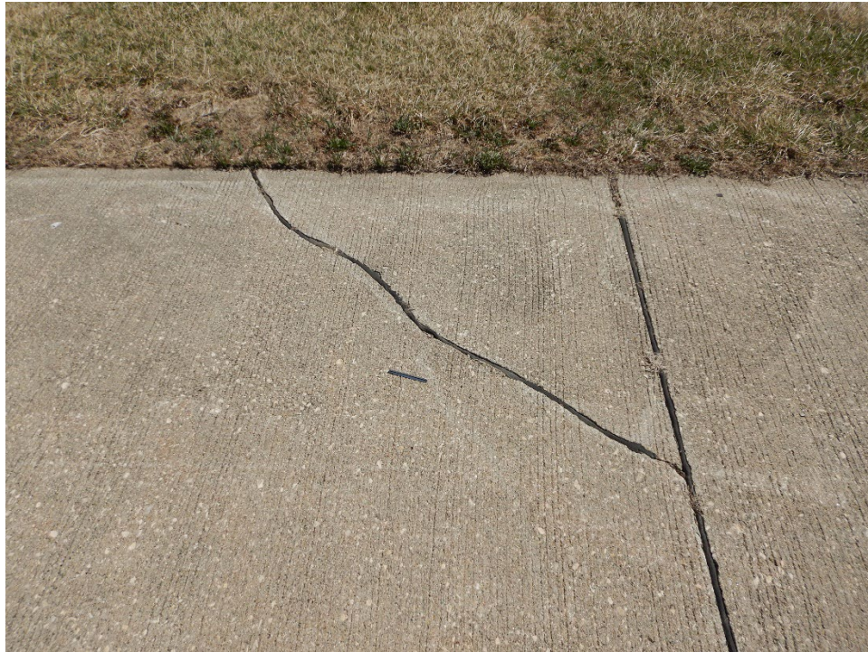
TCSL-01. Corner Break (Sample Unit No. 01).
