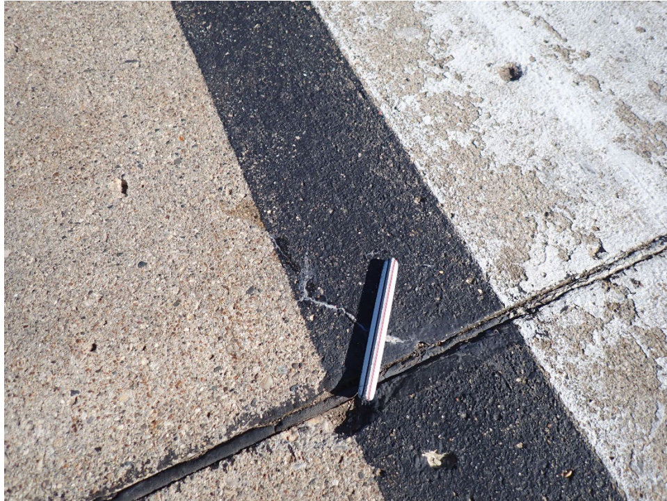
R17IS-01. ASR (Sample Unit No. 37).
