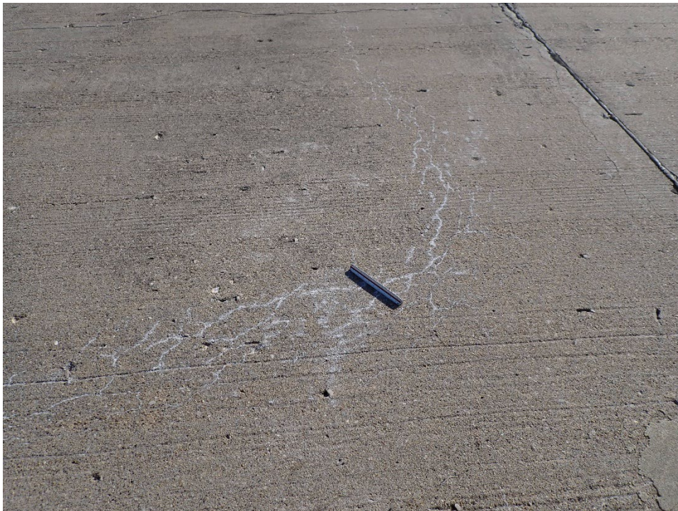
R16PE-05. ASR (Sample Unit No. 01) (1).
