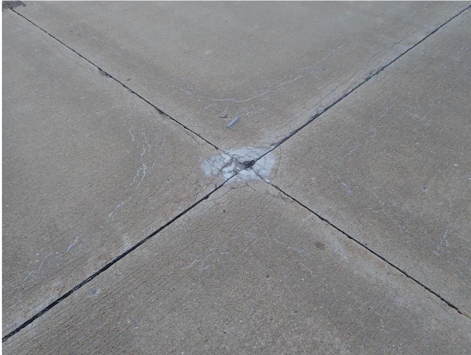
A01PE-02. ASR (Sample Unit No. 01).
