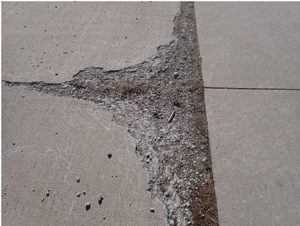
R16PE-11. ASR (Sample Unit No. 03).
