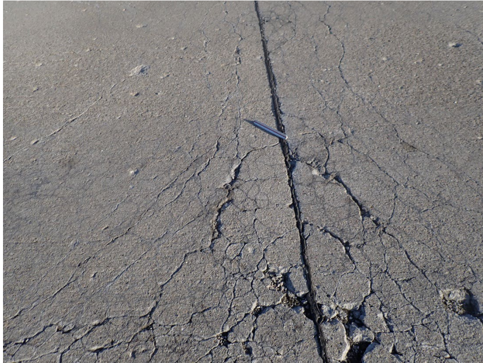
A01PE-01. ASR (Sample Unit No. 09).
