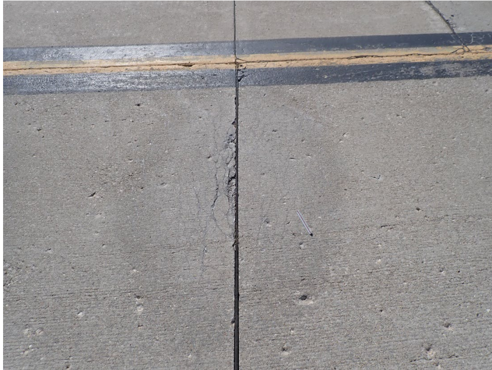
T01PE-01. ASR (Sample Unit No. 01).
