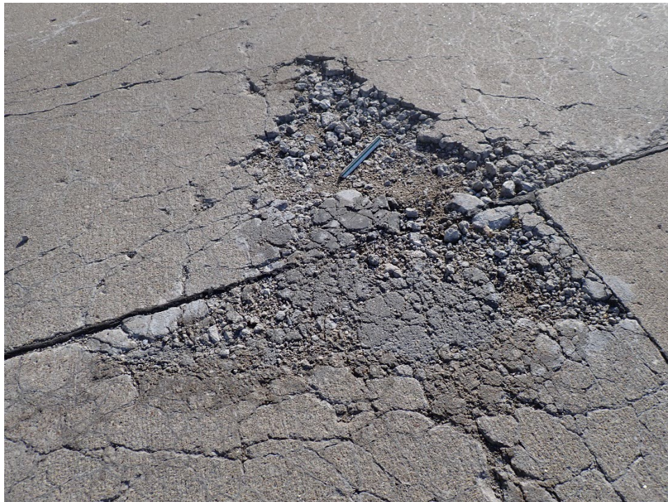
A01PE-01. ASR (Sample Unit No. 15).
