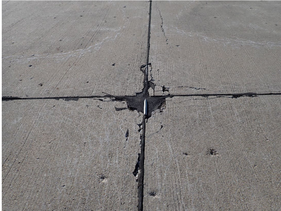
R16PE-05. ASR (Sample Unit No. 01) (2).
