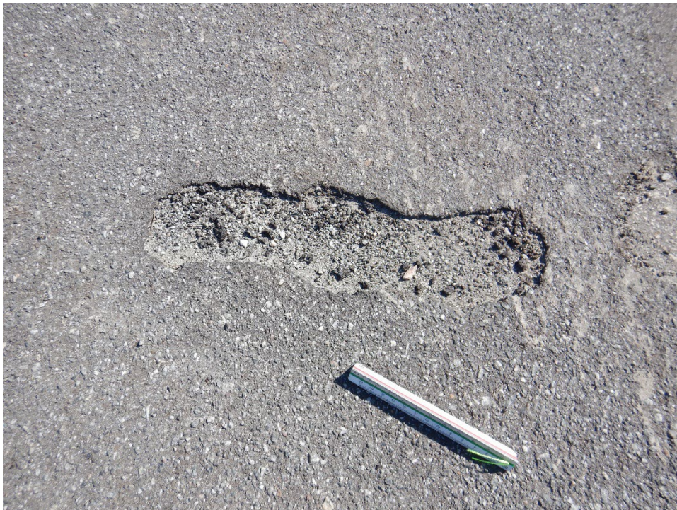
A02C2-03. Raveling (Sample Unit No. 03).
