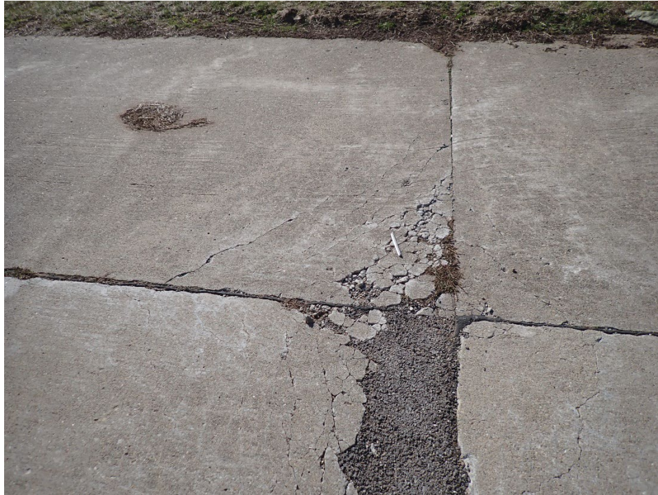
TH01KN-01. ASR (Sample Unit No. 04).
