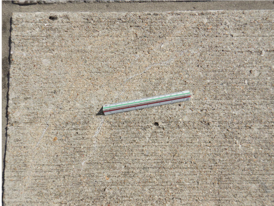
A02IC-01. ASR (Sample Unit No. 13).
