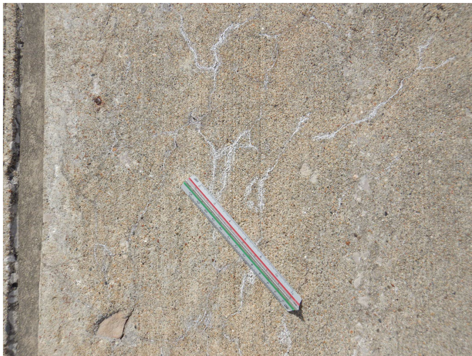
A02IC-01. ASR (Sample Unit No. 04) (2).
