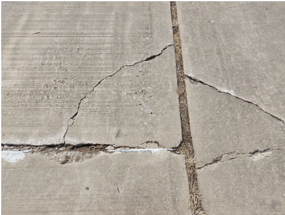
TH02IC-02. Corner Break (Sample Unit No. 08).
