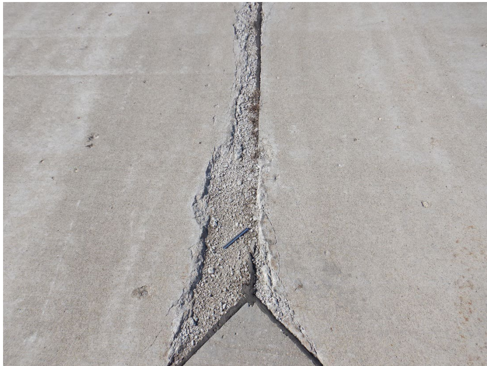
A01GL-01 ASR. (Sample Unit No. 02).
