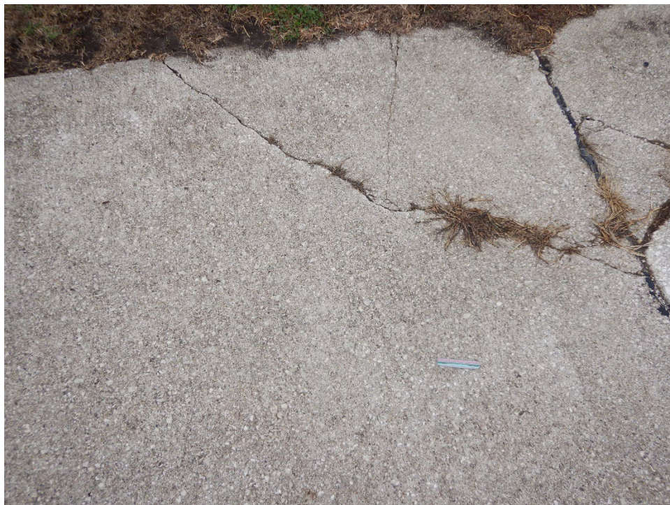
TH02GR-03. Corner Break (Sample Unit No. 01).
