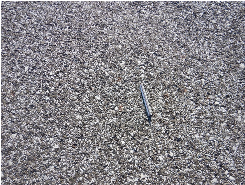
T02FC-01. Bleeding (Sample Unit No. 02) (2).
