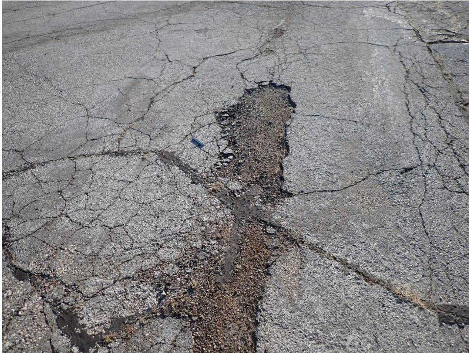
A01EG-01. Raveling (Sample Unit No. 02).
