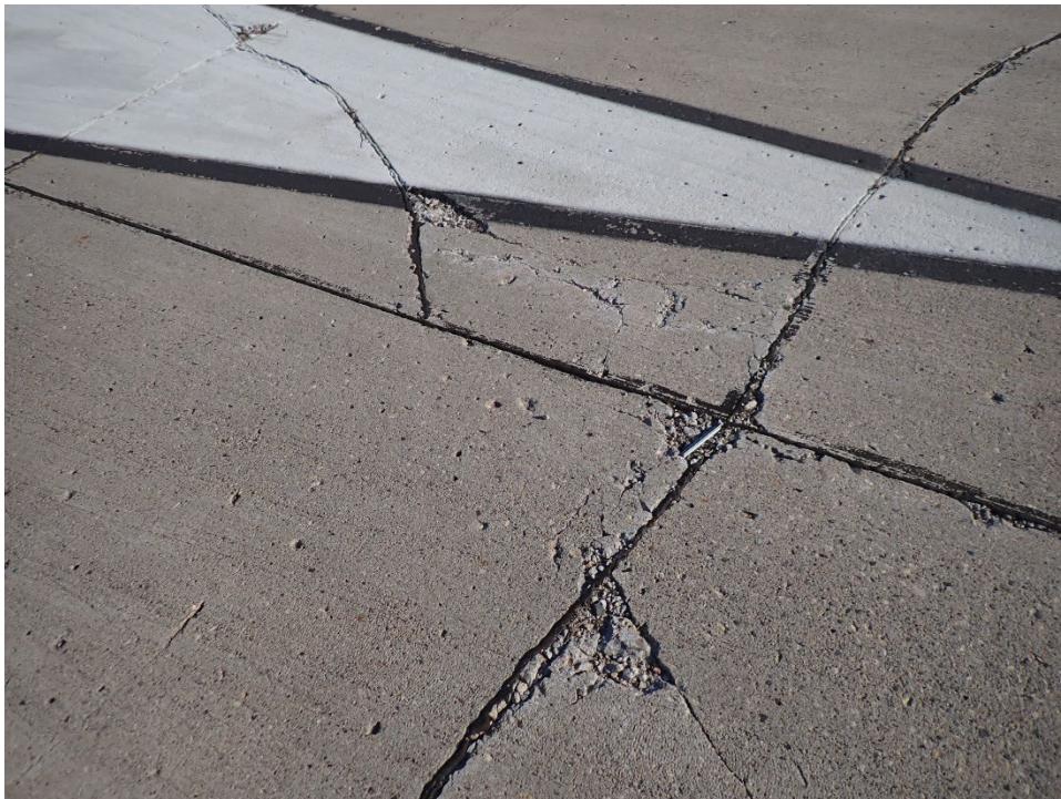
R13EG-01. ASR (Sample Unit No. 04).
