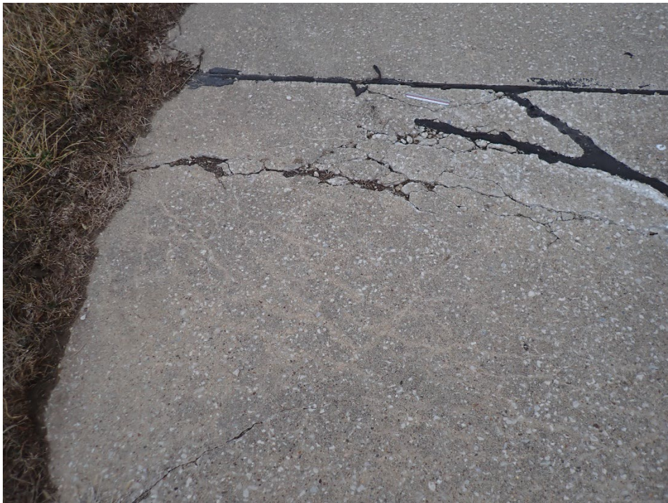
R12DN-04. ASR (Sample Unit No. 01).
