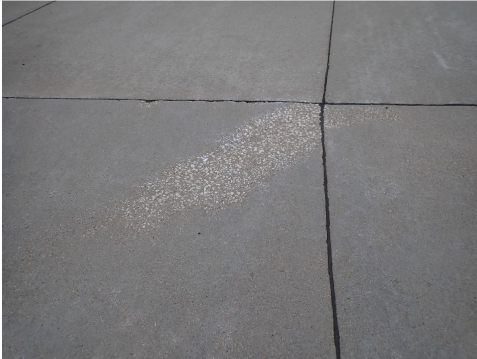
TH01DN-03. Scaling (Sample Unit No. 01).
