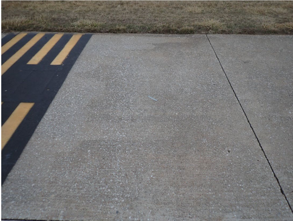
T01DN-03. Scaling (Sample Unit No. 01).
