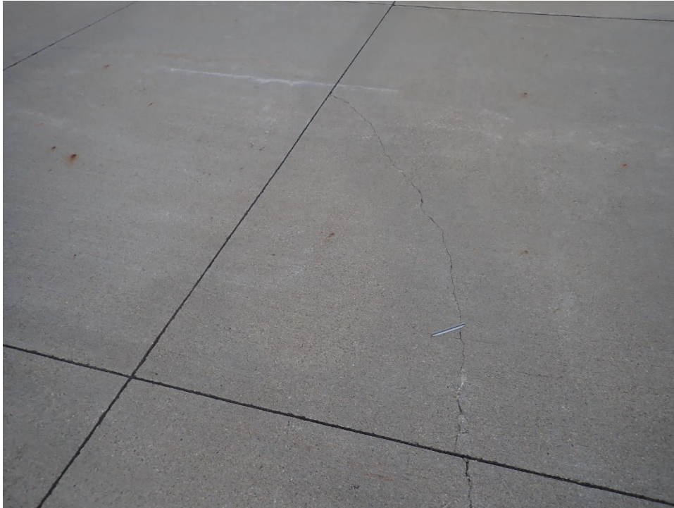
TH01DN-03. Corner Break (Sample Unit No. 01).
