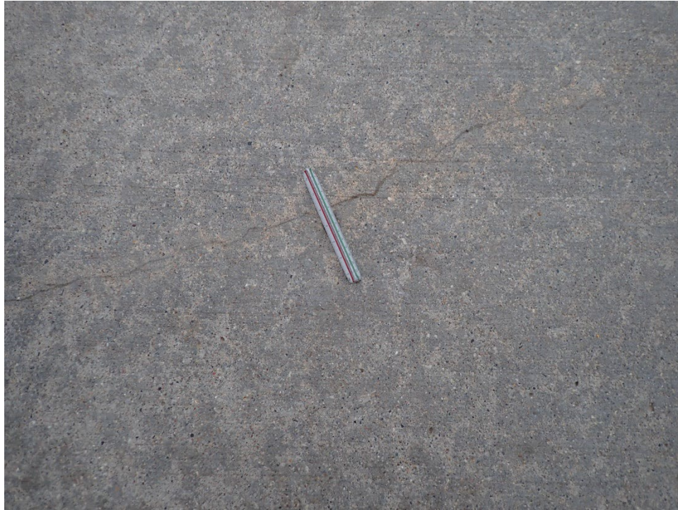
T01DN-02. ASR (Sample Unit No. 01).
