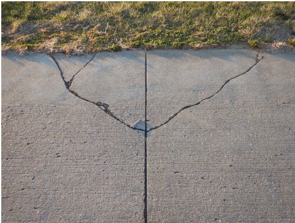
TH01CB-03. Corner Break (Sample Unit No. 03).
