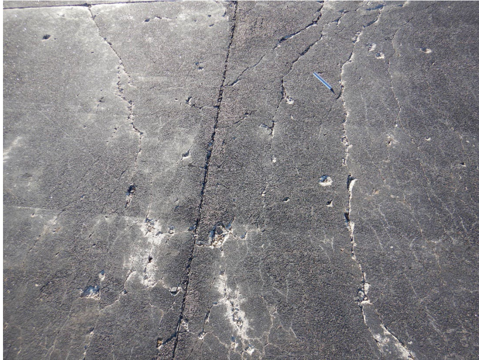
A02CN-01. ASR (Sample Unit No. 05).
