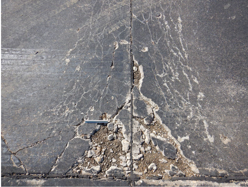
A01CN-01. ASR (Sample Unit No. 01) (1).
