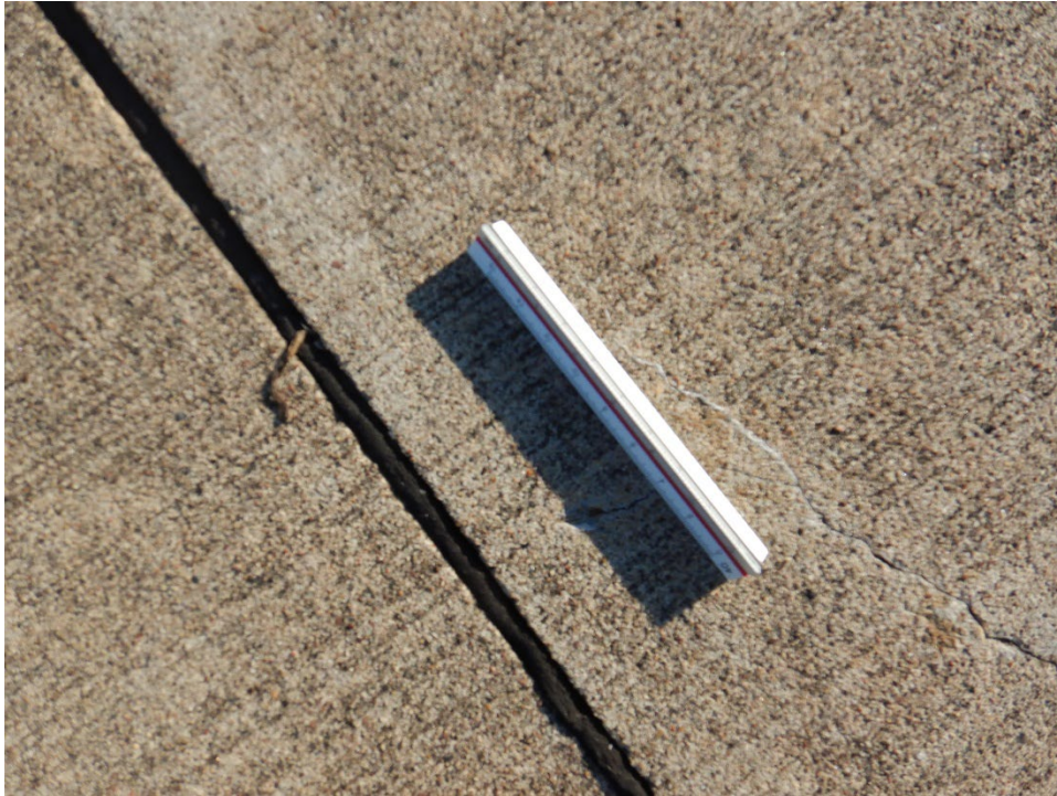
TA1CN-01. ASR (Sample Unit No. 04).
