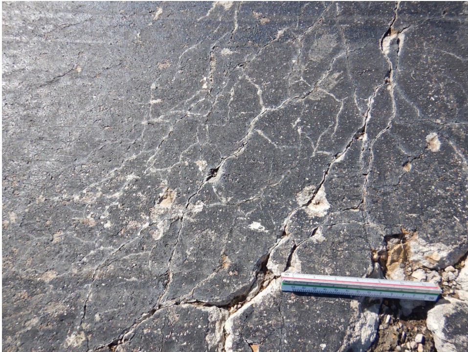
A01CN-01. ASR (Sample Unit No. 01) (2).
