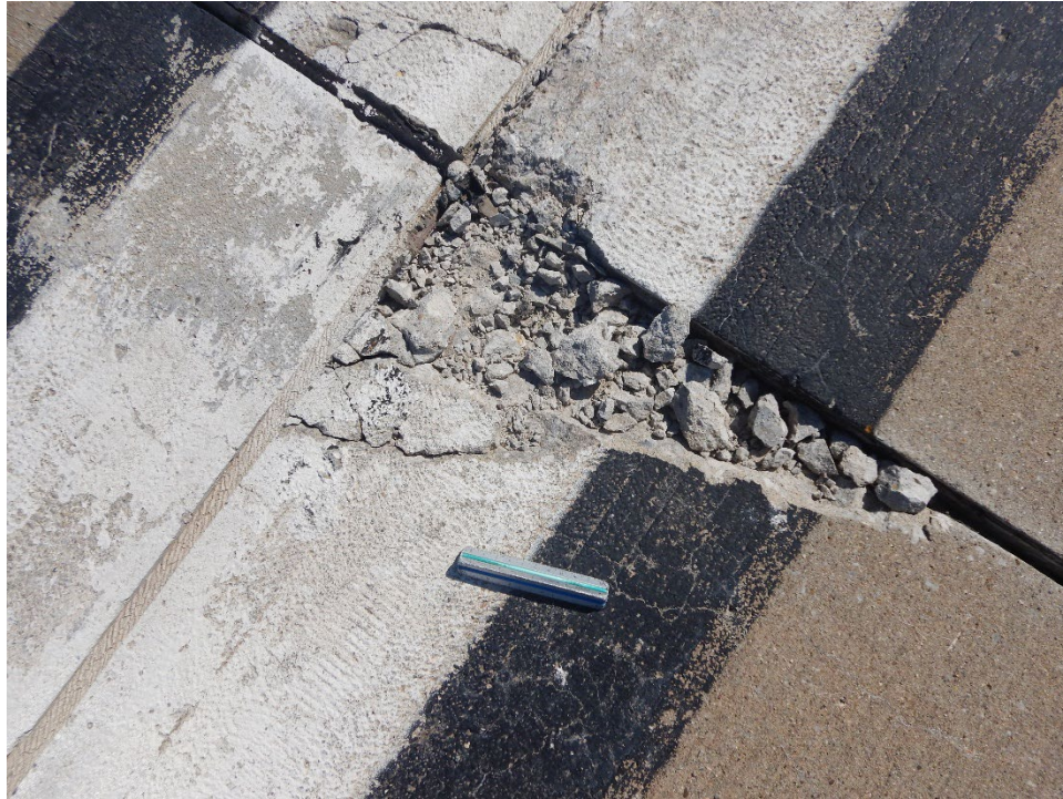
R02CD-01. ASR (Sample Unit No. 73).
