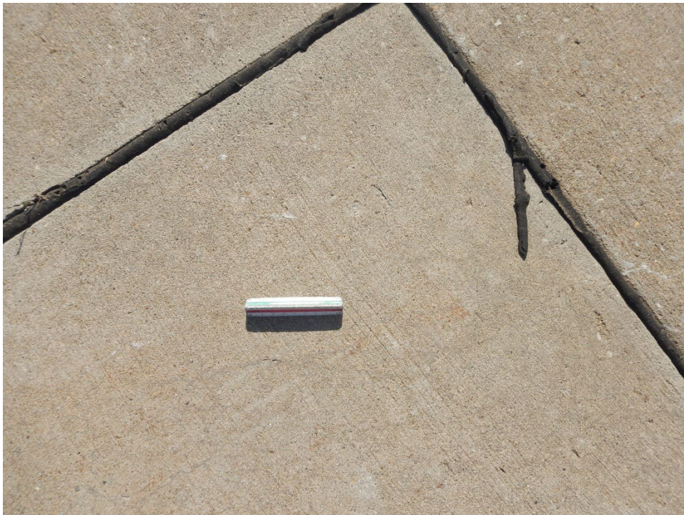
A01CD-01. ASR (Sample Unit No. 01).
