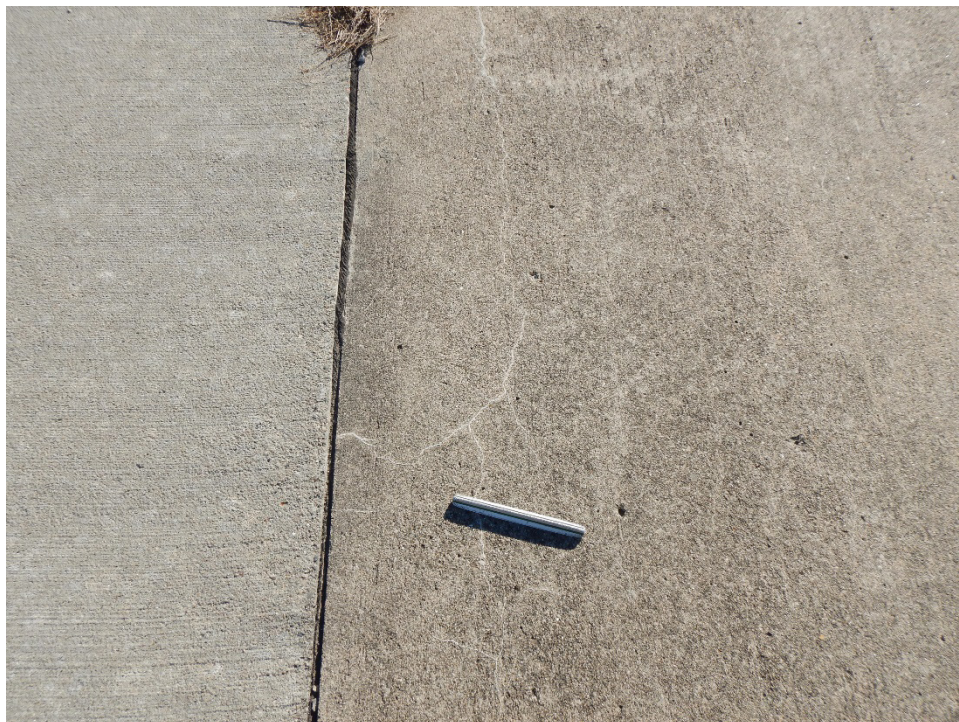
R16CE-01. ASR (Sample Unit No. 03).
