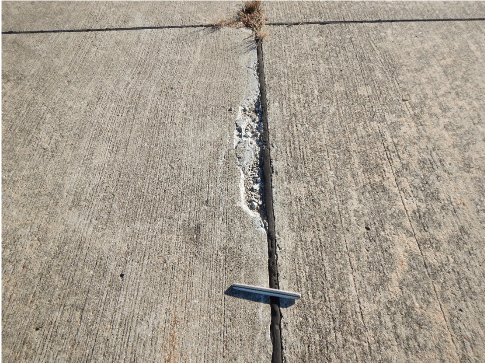
R16CE-02. ASR (Sample Unit No. 32).
