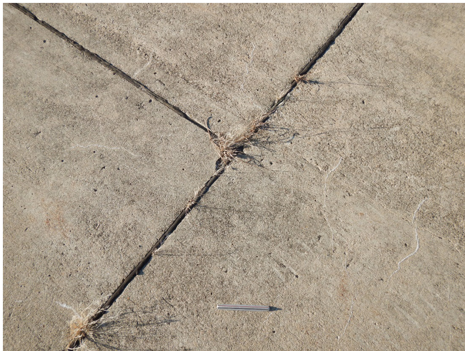
T01CE-01. ASR (Sample Unit No. 02).
