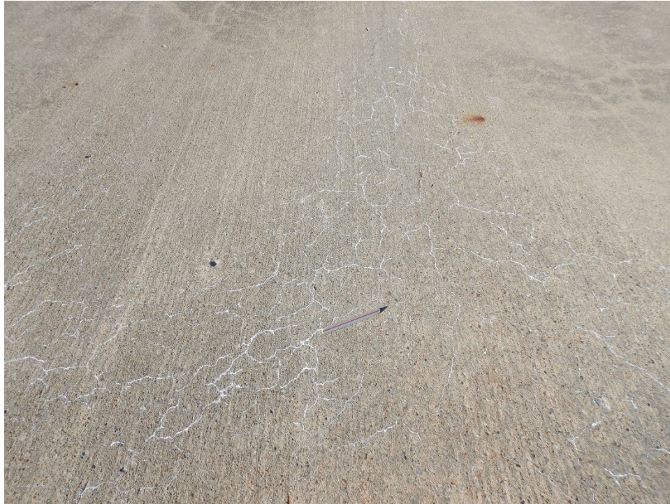
R16CE-03. ASR (Sample Unit No. 21).
