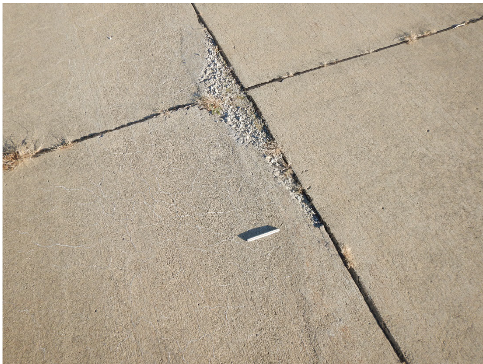
A01CE-01. ASR (Sample Unit No. 14).
