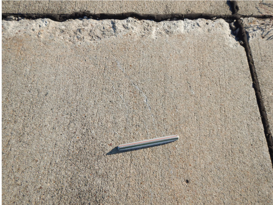
R16CE-04. ASR (Sample Unit No. 02).
