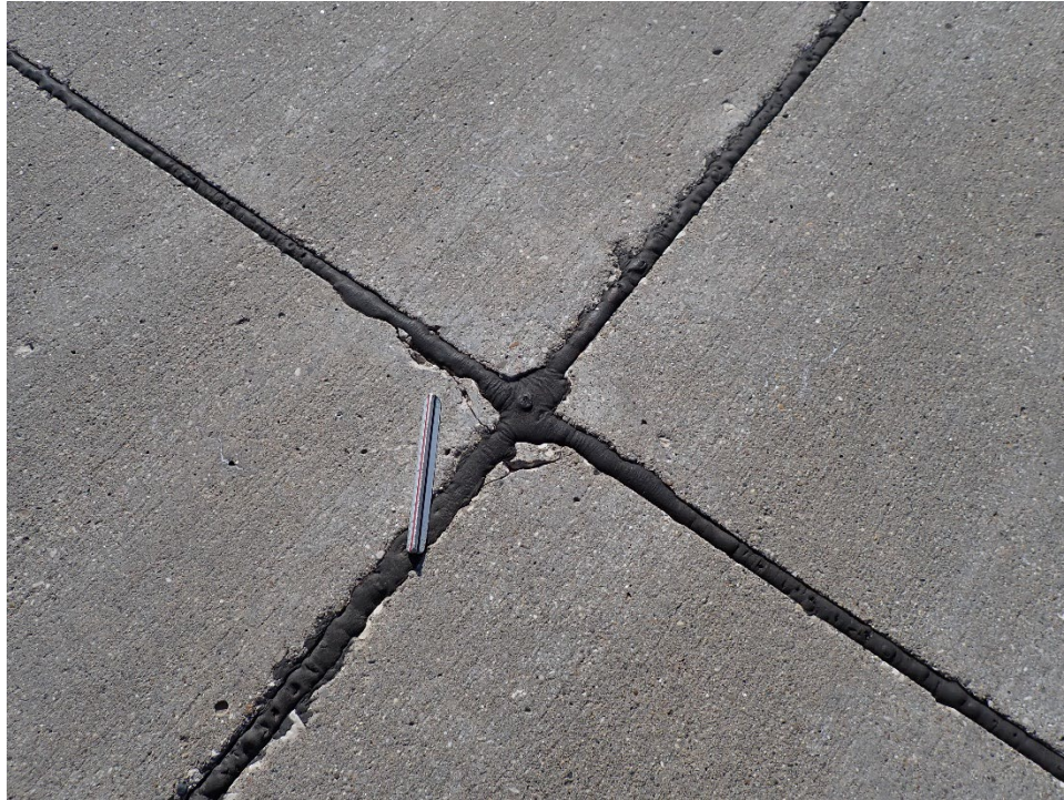
T04AN-01. ASR (Sample Unit No. 03).
