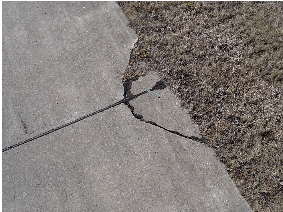
T06AN-01. Corner Break (Sample Unit No. 02).
