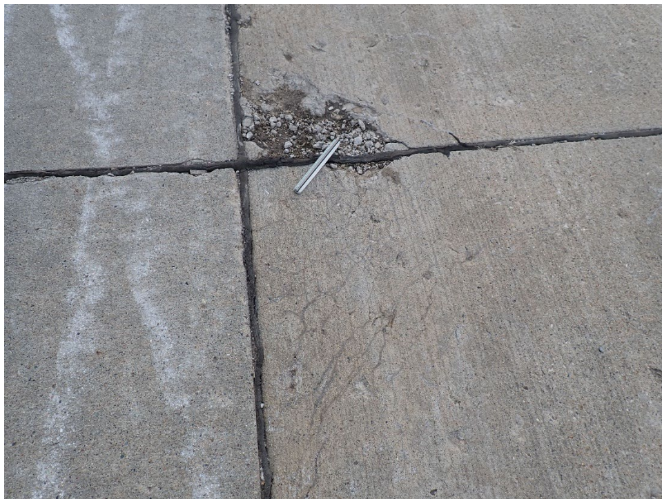
TH01AN-01. ASR (Sample Unit No. 01).
