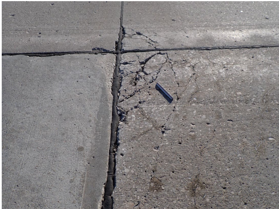
T02AN-01. ASR (Sample Unit No. 06).
