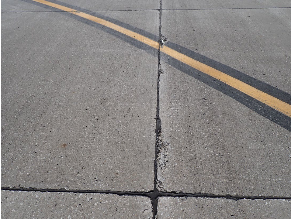
T03AN-01. ASR (Sample Unit No. 01).
