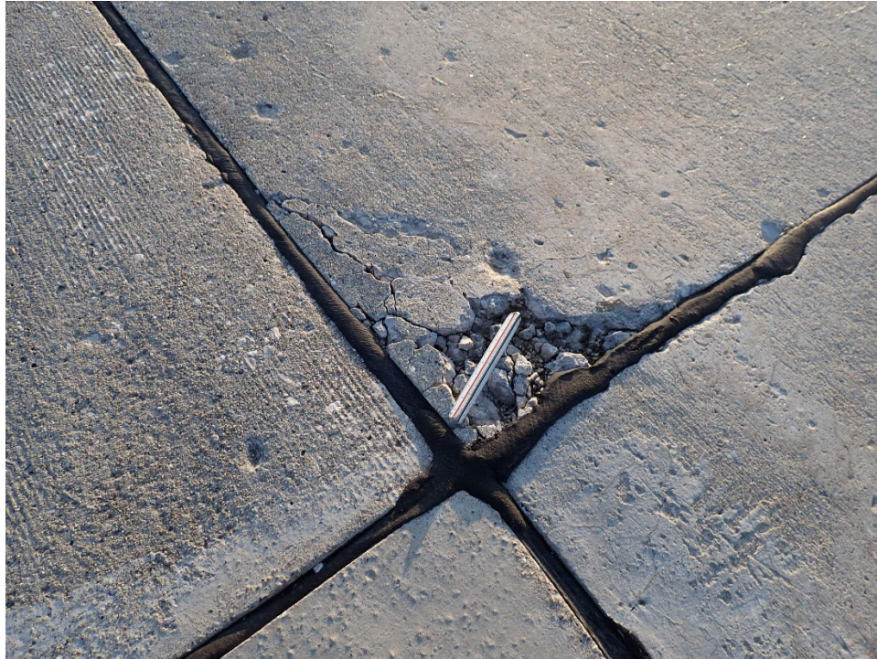
R04AN-03. ASR (Sample Unit No. 05).
