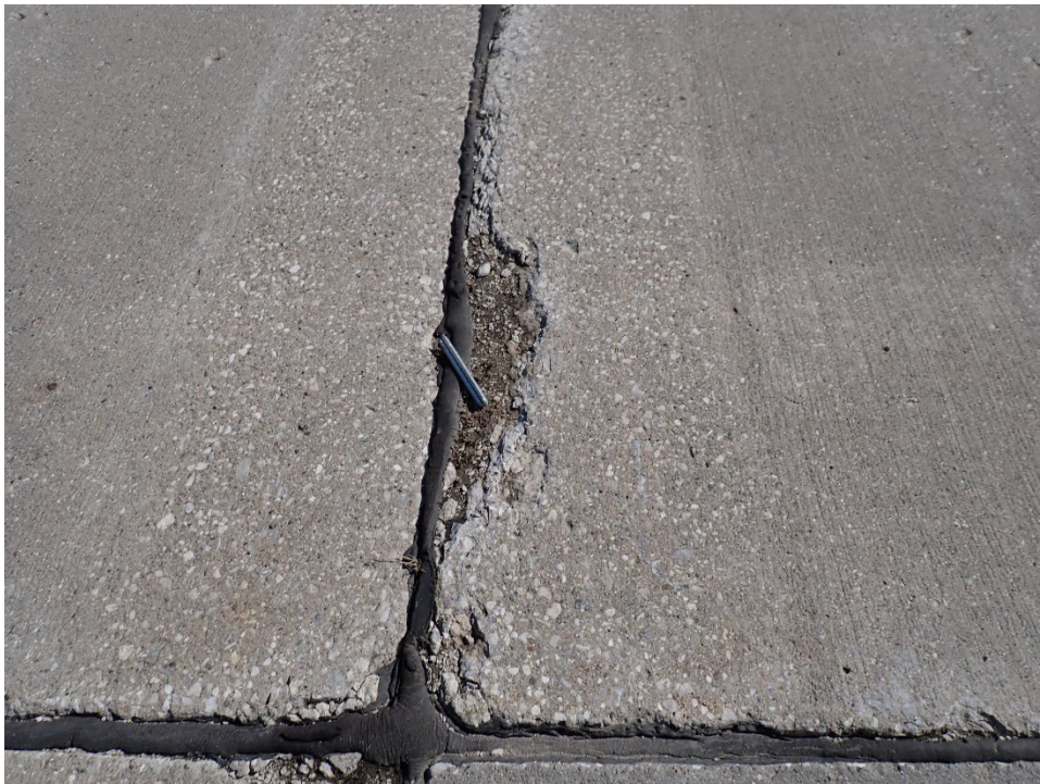
T08AN-01. ASR (Sample Unit No. 04).
