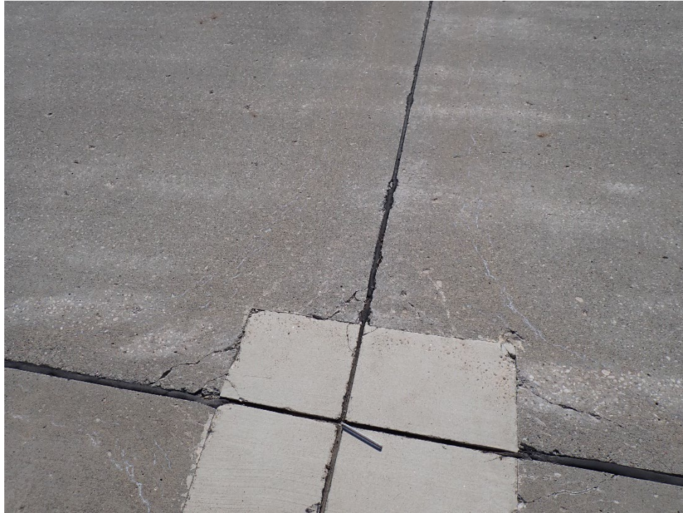
T03AN-01. ASR (Sample Unit No. 04).
