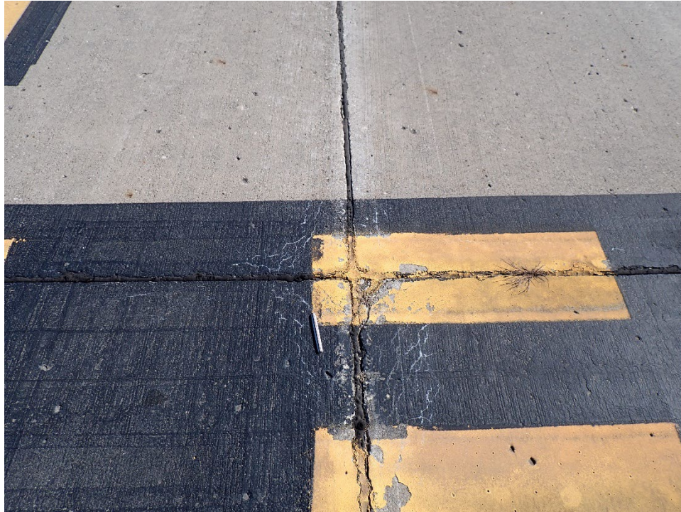
T08AN-01. ASR (Sample Unit No. 06).
