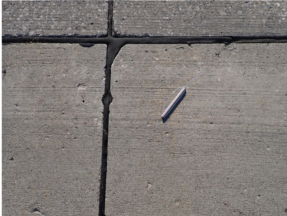
R04AN-02. ASR (Sample Unit No. 04).
