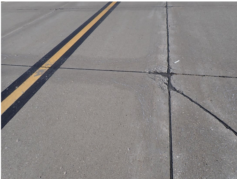
R04AN-04. ASR (Sample Unit No. 09).
