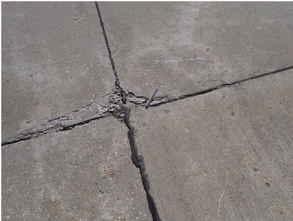
A01AN-02. ASR (Sample Unit No. 05).
