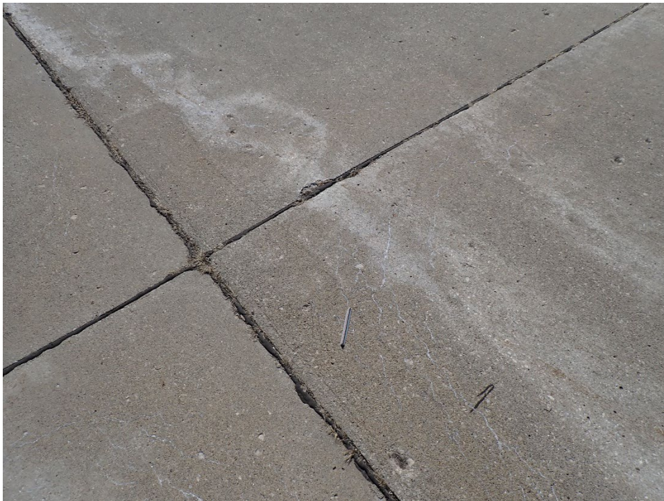
A01AN-01. ASR (Sample Unit No. 40).
