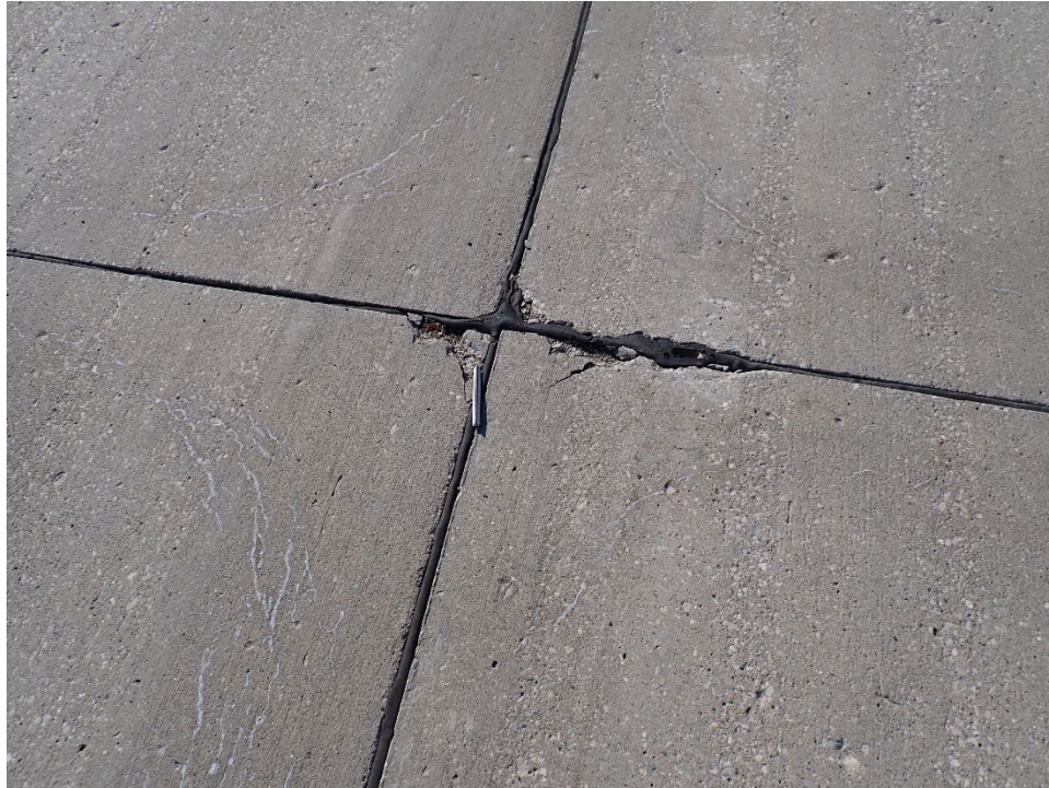
R18AN-01. ASR (Sample Unit No. 54).
