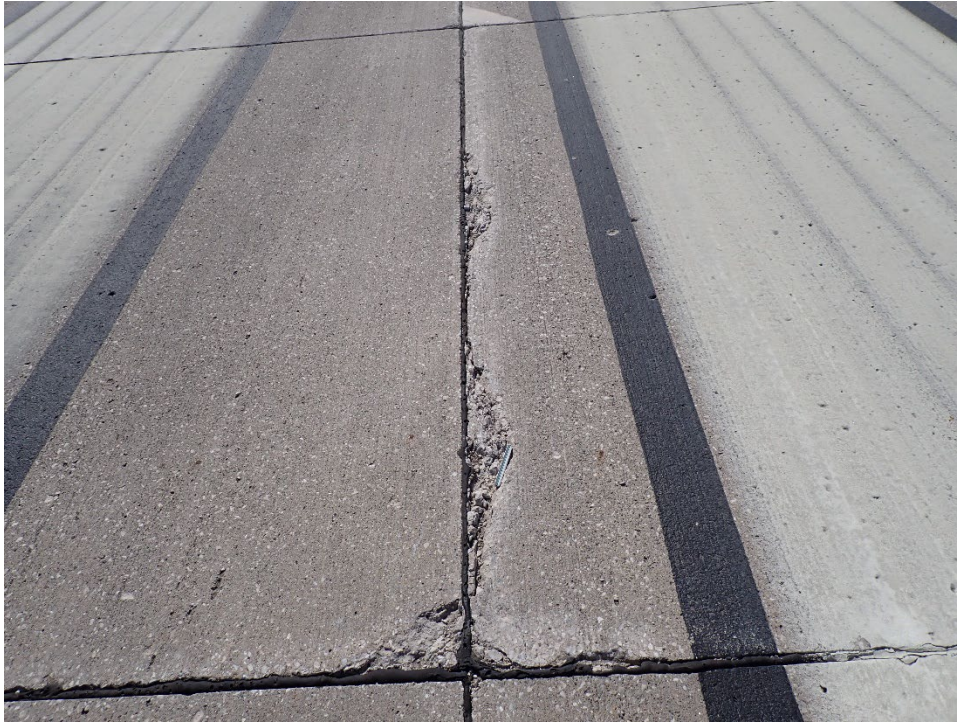
R04AN-04. ASR (Sample Unit No. 43).
