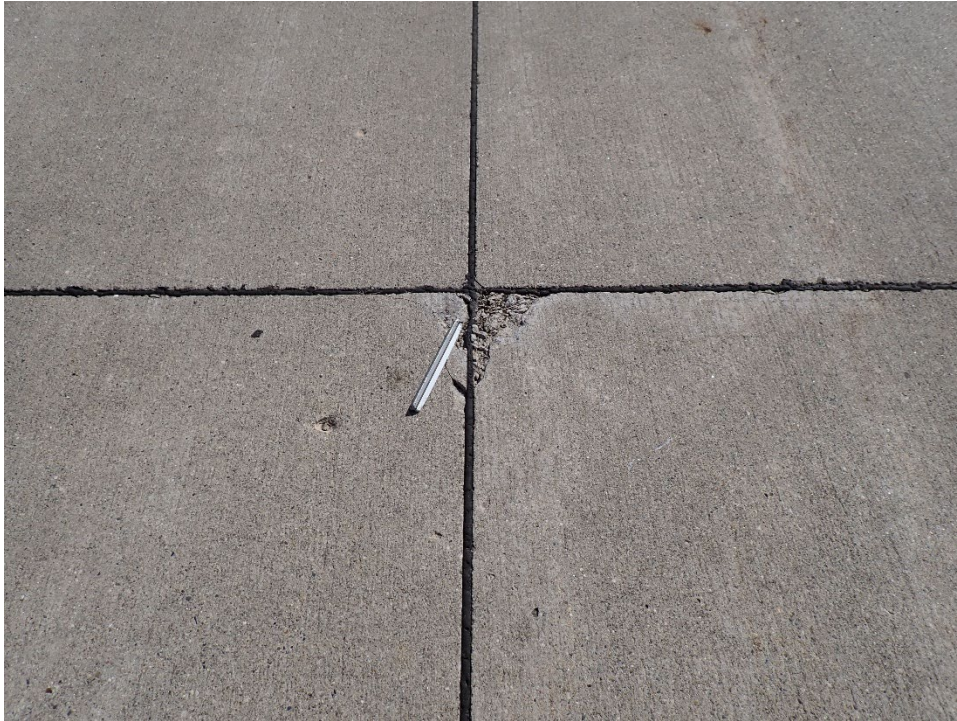
T13AN-01. ASR (Sample Unit No. 08) (2).
