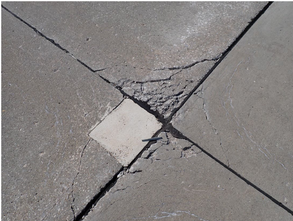
T03AN-01. ASR (Sample Unit No. 03).
