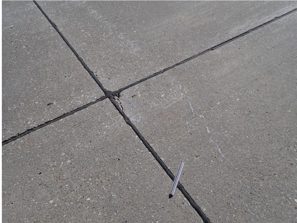
T06AN-01. ASR (Sample Unit No. 02).
