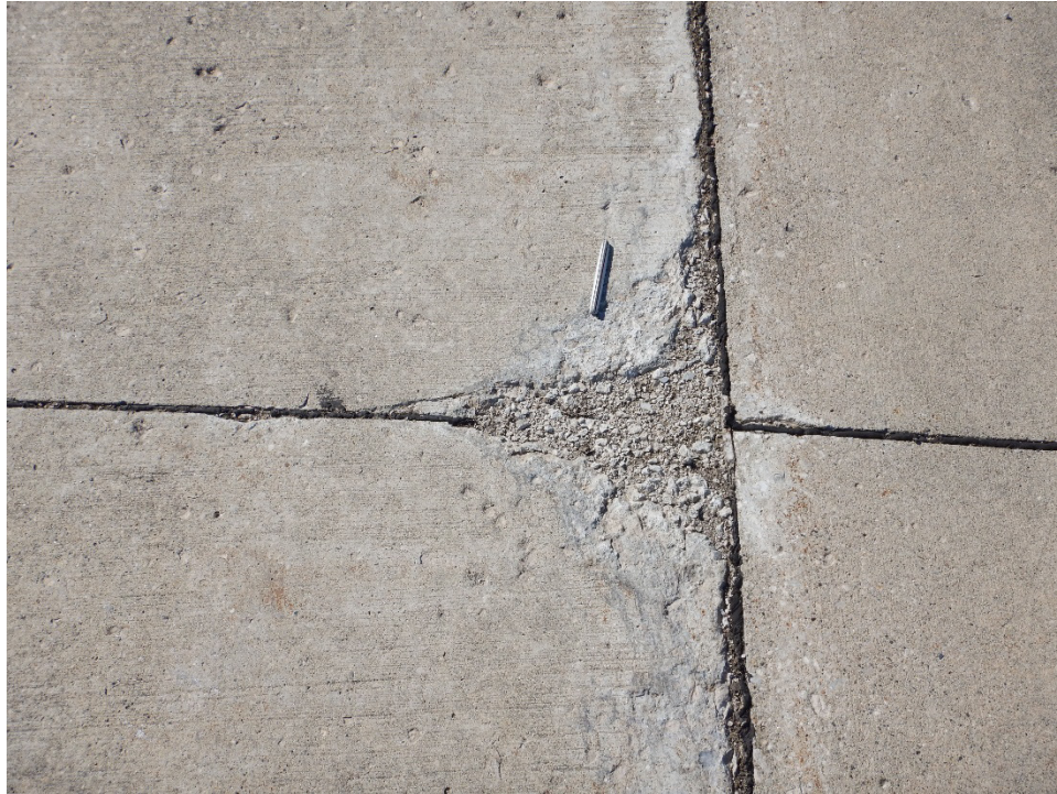
TA4AM-01. ASR (Sample Unit No. 04).
