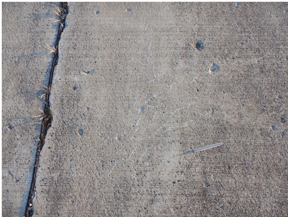
TAAM-10. ASR (Sample Unit No. 06) (1).
