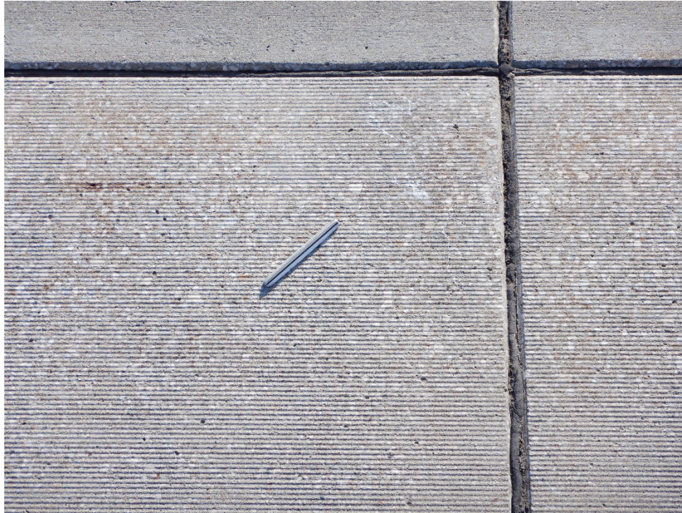
R13AM-04. ASR (Sample Unit No. 17).
