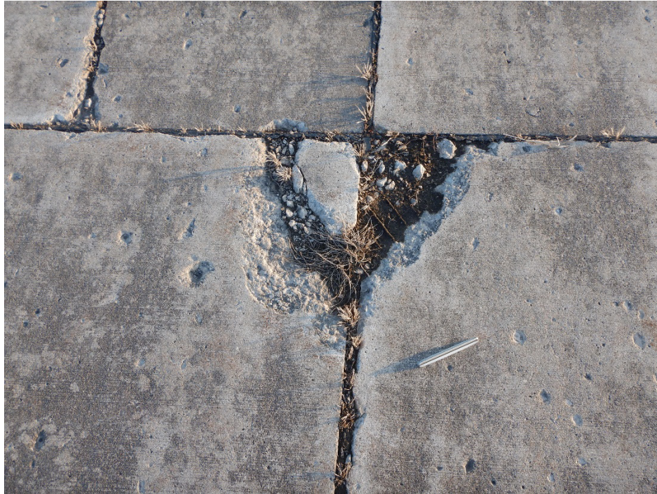
TAAM-10. ASR (Sample Unit No. 06) (2).
