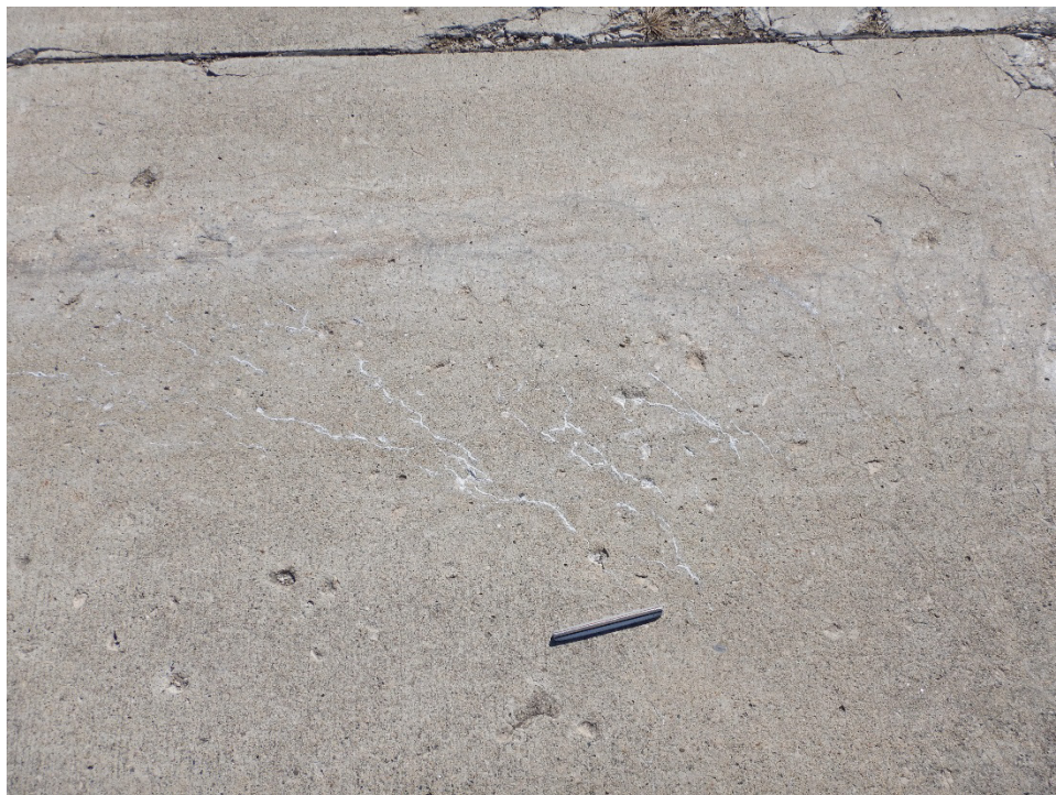
TA4AM-01. ASR (Sample Unit No. 05).
