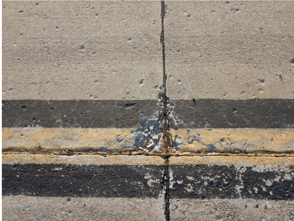
TAAM-09. ASR (Sample Unit No. 24).
