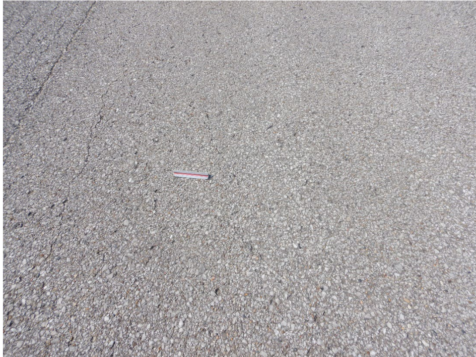
R13AL-03. Raveling (Sample Unit No. 08).
